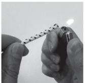
Die Schnur muss bei heruntergelassenem Rollladen ca. 25 cm über den Klemmer des Wicklers herausragen. Gegebenfalls kürzen und Ende verschweissen.
