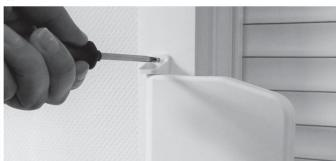
Schnurwickler in der gewünschten Position anschrauben (möglichst lotrecht unter dem Schnuraustritt am Rollladenkasten).
